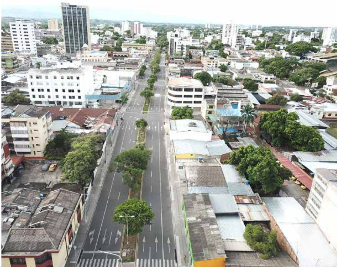
La obra de la Carrera Séptima, también fue inspeccionada y ajustada para poder ser recibida a satisfacción.
