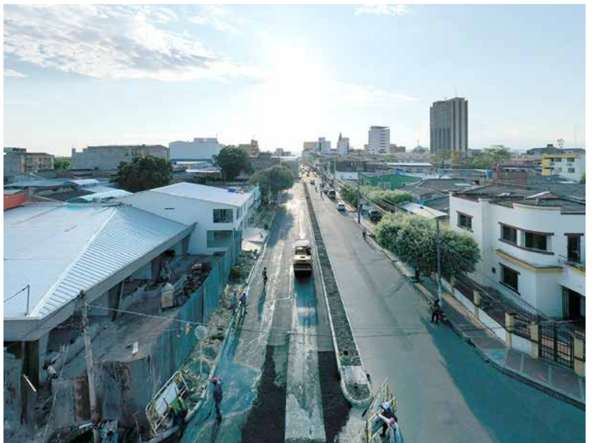
Esta vía se construyó en tiempo record, gracias al equipo de la Secretaría de Vías e Infraestructura
