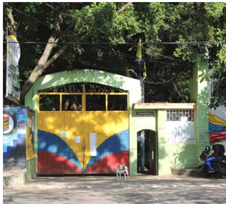
El Colegio Nacional Santalibrada tuvo que cerrar un sector, por daños en infraestructura.
